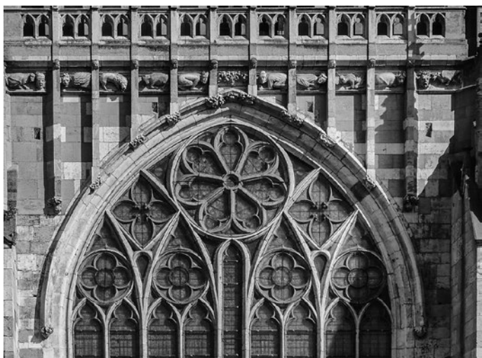
Abb. 16 Regensburg, Dom, Südquerhaus, Fenstermaßwerk und Wandgliederung darüber (Foto: A. Hubel)
