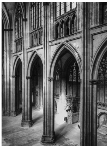
Abb. 15 Regensburg, Dom, Langhaus, Blick von Südosten auf die Nordwand des Mittel- schiffs (Foto: A. Hubel)
