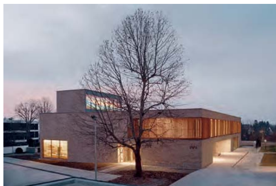
Abb. 1 Stuttgart-Bad Cannstatt, St. Peter, Kamm Architekten Stuttgart, 2016–18
