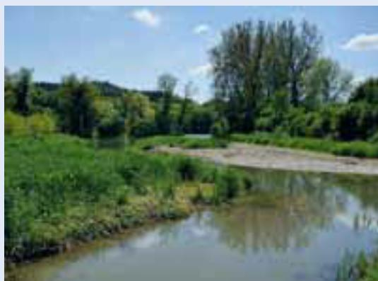
**2.1.29 | Bei der Renaturierung der Wutachmündung** im Jahr 2010 wurde die Überflutungsaua des Hochrheins durch Geländetieferlegung erheblich vergrößert und durch Öffnen der Flussdeiche an die Wutach angebunden. (KS.2013)
