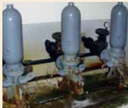
5.1.14 | Der hydraulische Widder, der mit der starken Quellschüttung das Wasser stoßweise hochdrückte, wurde 1957 von der Gemeinde Reiselfingen installiert. (CM.2001)
