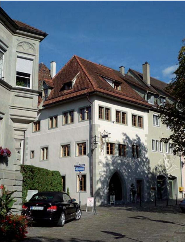
5 Überlingen, Münsterplatz 3. Das ehemalige Kaplaneipfründhaus konnte im massiven Erdgeschoss anhand einer Mauerlatte auf 1320 (d) datiert werden, während die Bohlenstube im 1. OG und das Fachwerk des 2. OG dendrochronologisch auf 1484/85 zu datieren sind. Es bildet den Auftakt zu der Zeile traufständiger Häuser an der nördlichen Münsterplatzseite.
