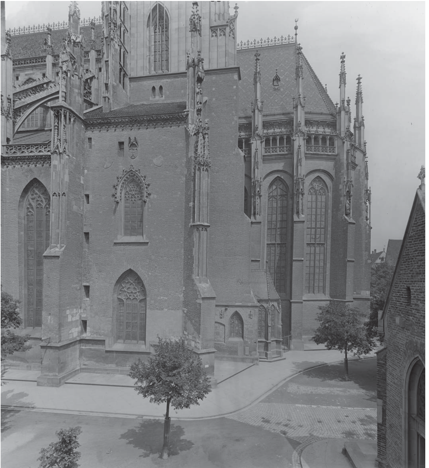
Abb. 1: Der Ulmer Münsterchor von Süden, historische Aufnahme (Messbildstelle, Dresden)
