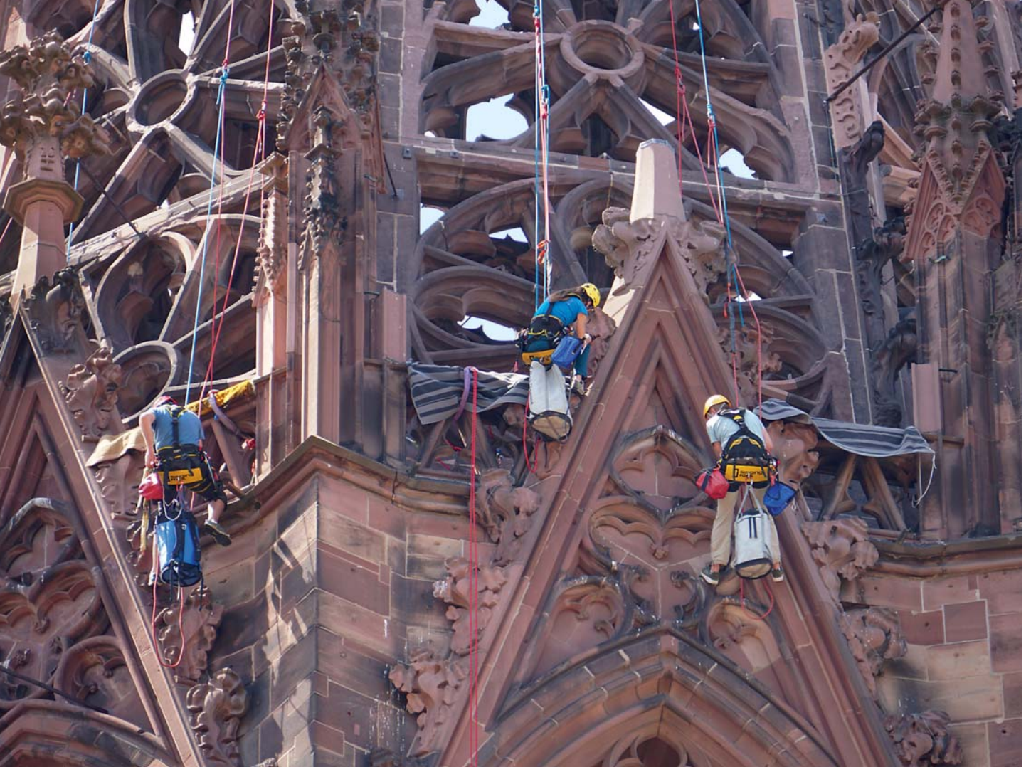
Abb. 4: Prüfende Bekletterung des Turmhelms durch die Freiburger Münsterbauhütte, 2019
