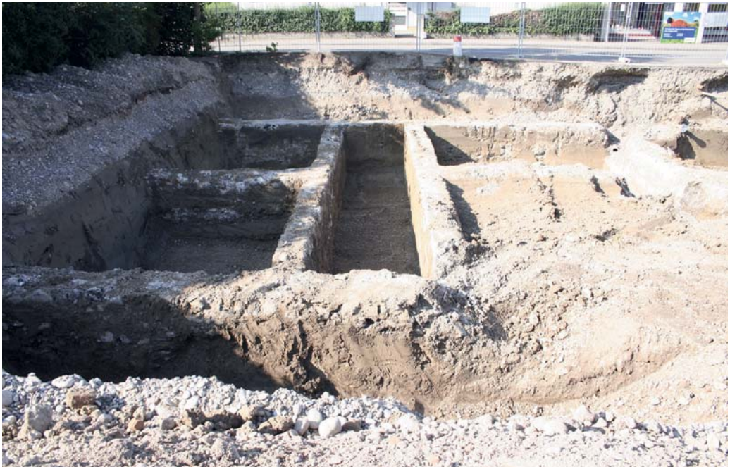
Abb. 3: Breisach, Kupfertorstraße 28. Fundamente vaubanzeittlicher Kasernenbauten. Foto: LAD, Diethard Tschocke.
