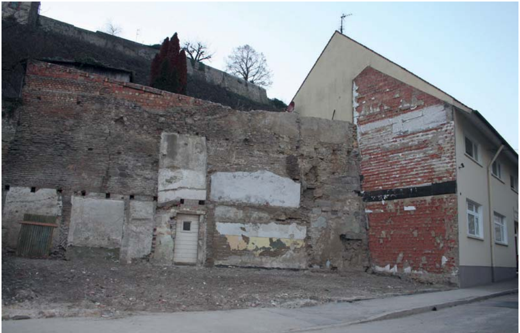
Abb. 4: Nach dem Abbruch von Gebäuden an der Muggensturmstraße wurde 2007 ein Teilbereich der Brei- sacher Festungsmauer freigelegt. Foto: LAD, Bertram Jenisch.
