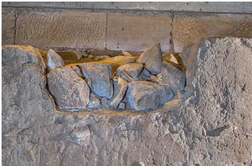
Abb. 2: Die erhaltene untere Lage der Fundamentmauer (I fm 1) im Profil gegen Norden. Das Mauerwerk füllt die Baugrube vollständig aus (Iris Geiger-Messner, Landesamt für Denkmalpflege im Regierungspräsidium Stuttgart)
