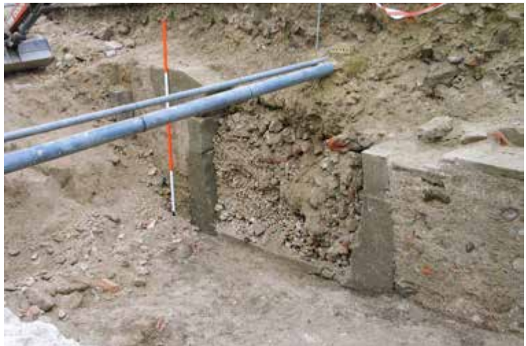
Abb. 6: Eine Besonderheit sind die für das Einbringen von Fässern gebaucht gestalteten Türleibungen in den Kellern, hier von dem Domherrenhof am Stauf auf dem Münsterplatz.
