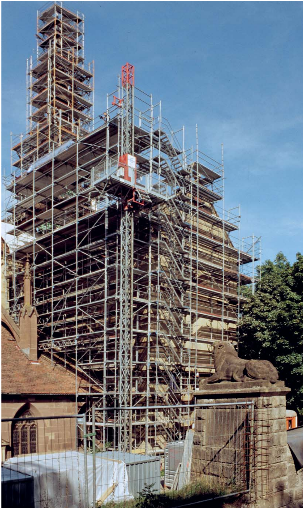
1 Baugerüst an Südquerarm und Dachreiter, 2003.
