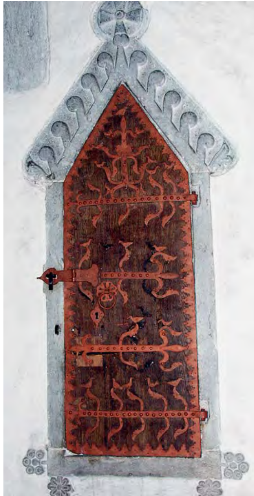
10 | oben Bohlentür eines Wandschranks mit Eisenbeschlägen. Ende 13. Jh. Gotland, Lärbro, Pfarrkirche.
