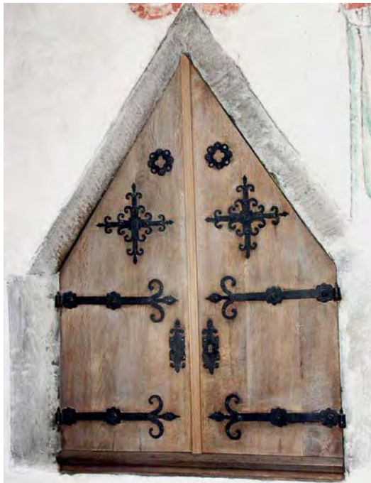
8 Bohlentüren eines Wandschranks mit Eisenbeschlägen. Ende 13. Jh. Gotland, Öja, Pfarrkirche.
