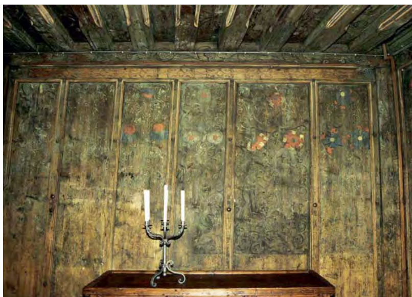
22 Farbig bemalte Wand einer Bohlenstube. 4. Viertel 15. Jh. Burg Reifenstein bei Sterzing.
