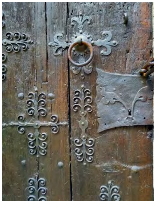
6 | links Bohlentür mit Eisenbeschlägen. Um 1285/90. Regensburg, Dom, Annenkapelle im nördlichen Annexbau des Hauptchors.
