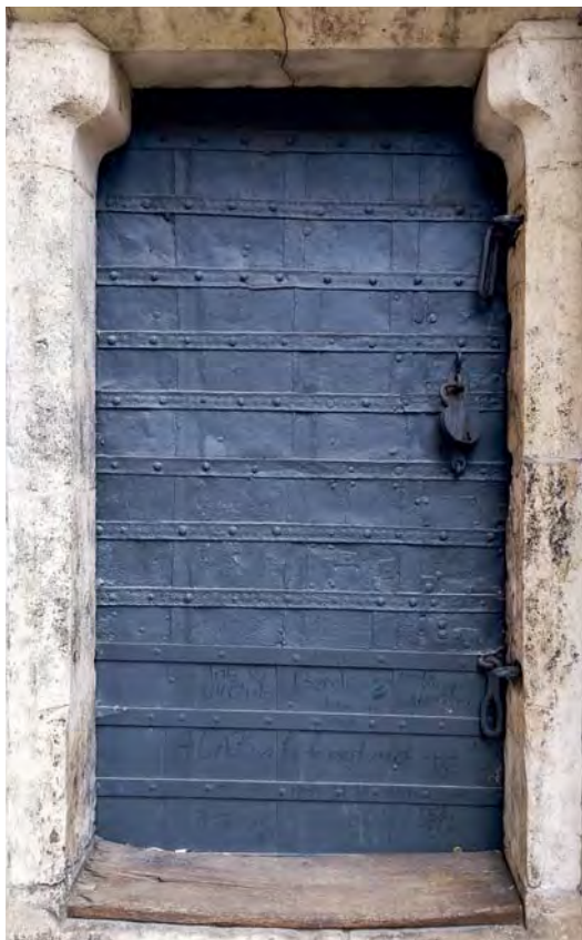
13 Mit Eisenblech überzogene Bohlentür. Um 1340. Regensburg, Dom, Nikolauskapelle im südlichen Annexbau des Hauptchors.
