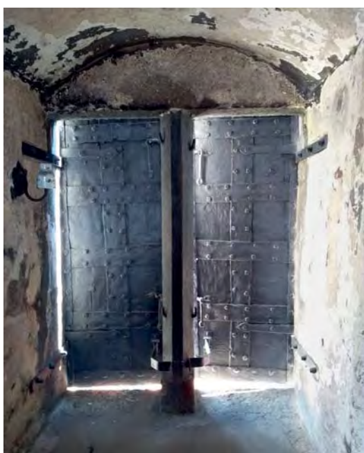
14 Eiserne Fensterläden. 3. Viertel 13. Jh. Regensburg, sog. Baumburger Turm, Watmarkt 4, 6. OG, Ostfassade.
