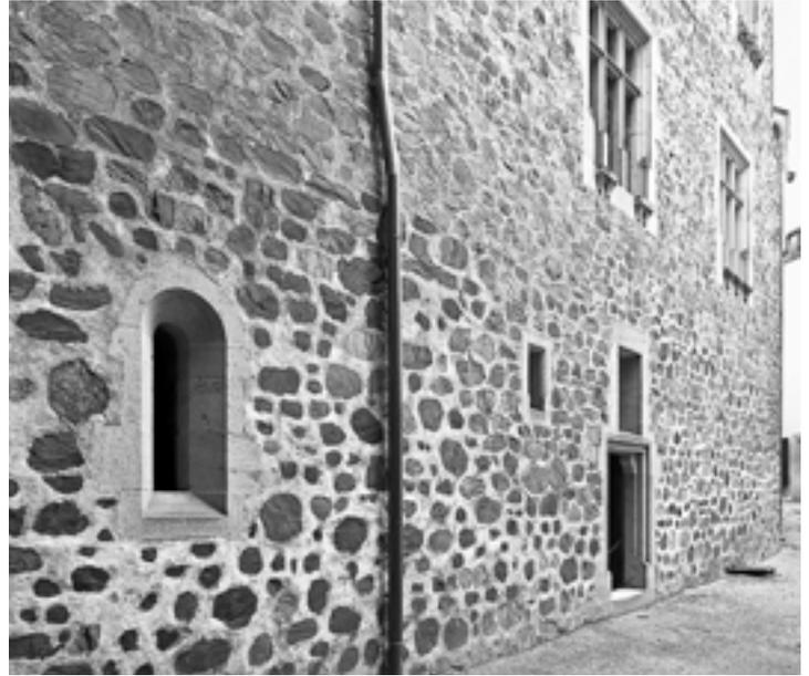
Abb. 2 Pürglitz, Burg. Erdgeschossfassade des Nordflügels der Oberburg nach der Wiederherstellung durch Kamil Hilbert in den 1920er Jahren. Ganz links die Replik eines Fensters mit romanischem Charakter. (Aufnahme: J. Veselý, 2008)
