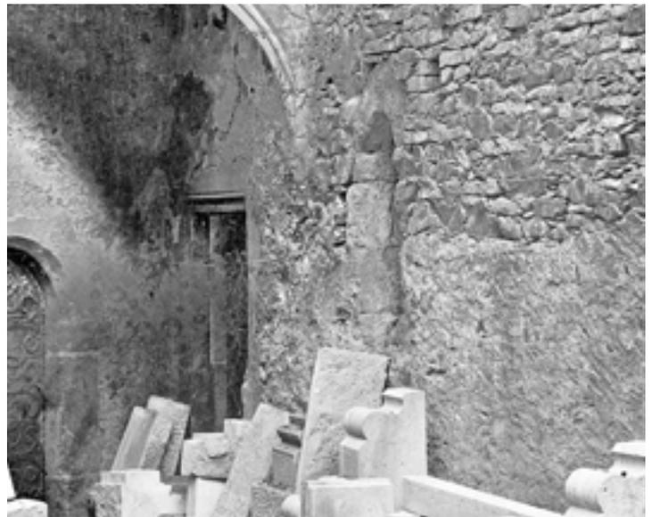
Abb. 3 Pürglitz, Burg. Erdgeschossfassade des Nordflügels der Oberburg vor der Wiederherstellung. In der Mitte sichtbar die ursprüngliche, stark verwitterte Fensterumrahmung romanischen Charakters; die Komposition entspricht ganz den übrigen ähnlichen Fenstern im Burgareal. (Foto: Fotoarchiv NPÚ ÚP v Praze)
